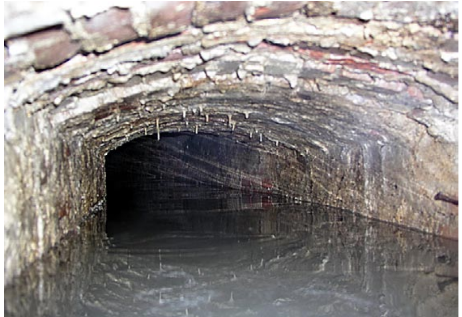
Gewölbegang im neu entdeckten Sodbrunnen des Margarethenguts. Er ist etwa 1,5 Meter hoch mit Wasser geflutet.
